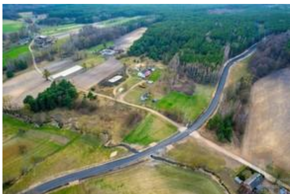
Przebudowa drogi Grabie Polskie–Okolusz– Strzemeszno–Czermno – widok z drona
