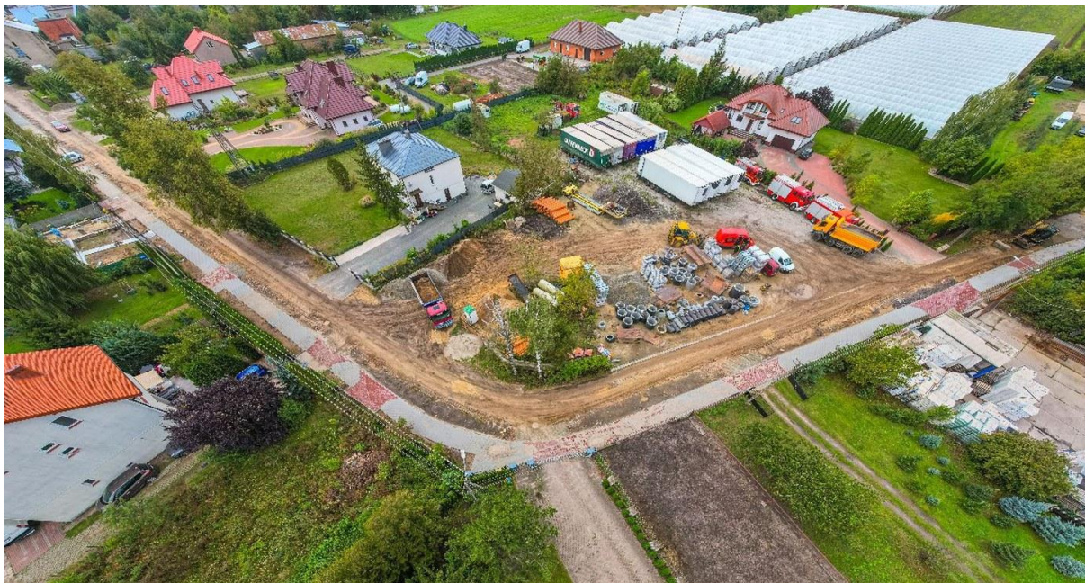
Ul. Rogatki Żychlińskie – widok z drona podczas realizacji inwestycji drogowej
