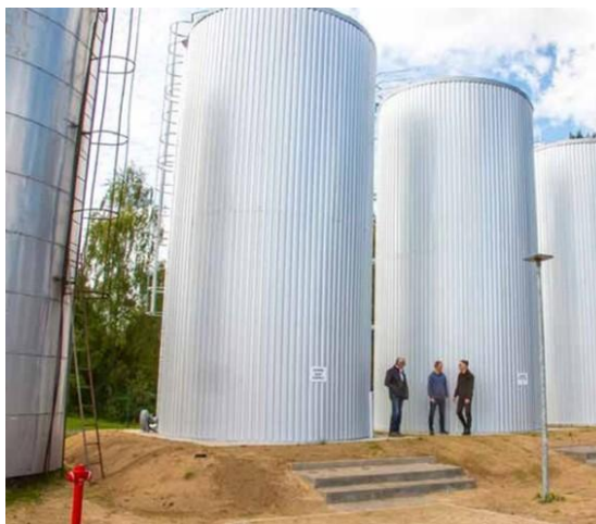
Zbiorniki retencyjne przy SUW Kępina – nowo wybudowane pojemniki 3 × 150 m 3
