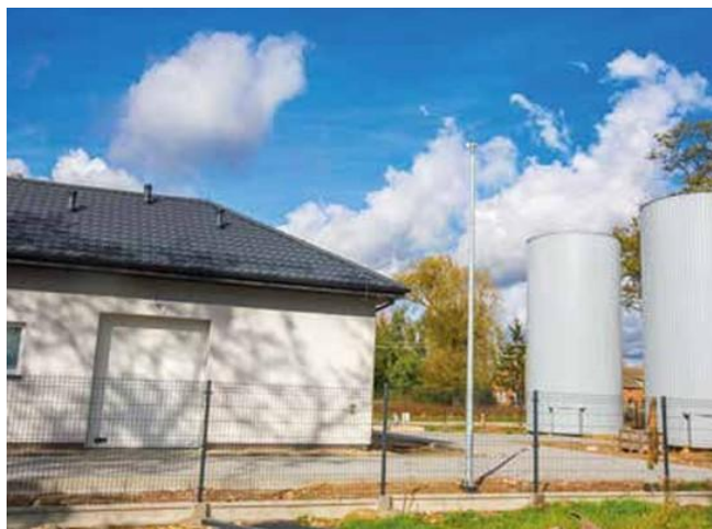
Stacja Uzdatniania Wody Kamień Słubice po przebudowie – budynek i zbiorniki
