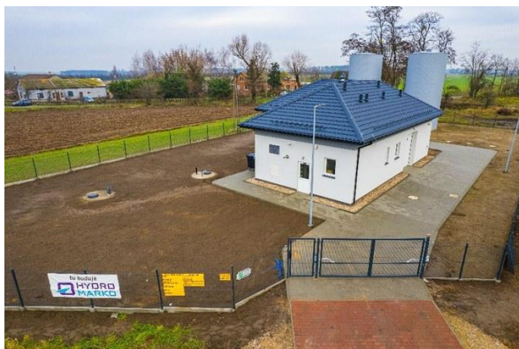
Stacja uzdatniania wody w Kamieniu Słubice – obiekt po zakończeniu budowy
