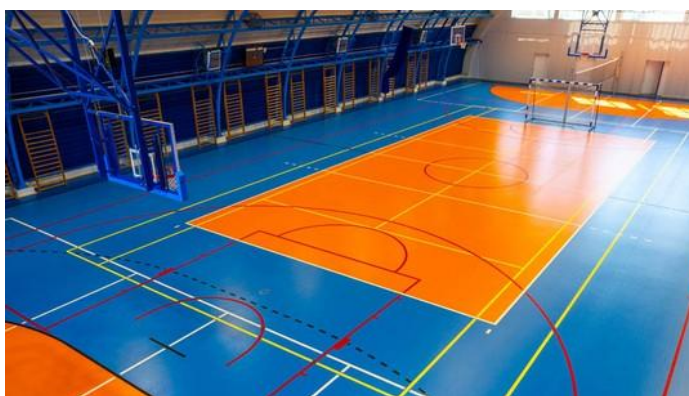
Hala sportowa w Gąbinie po remoncie – nowa nawierzchnia sportowa
