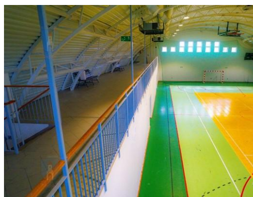
Hala sportowa w Dobrzykowie po termomodernizacji
