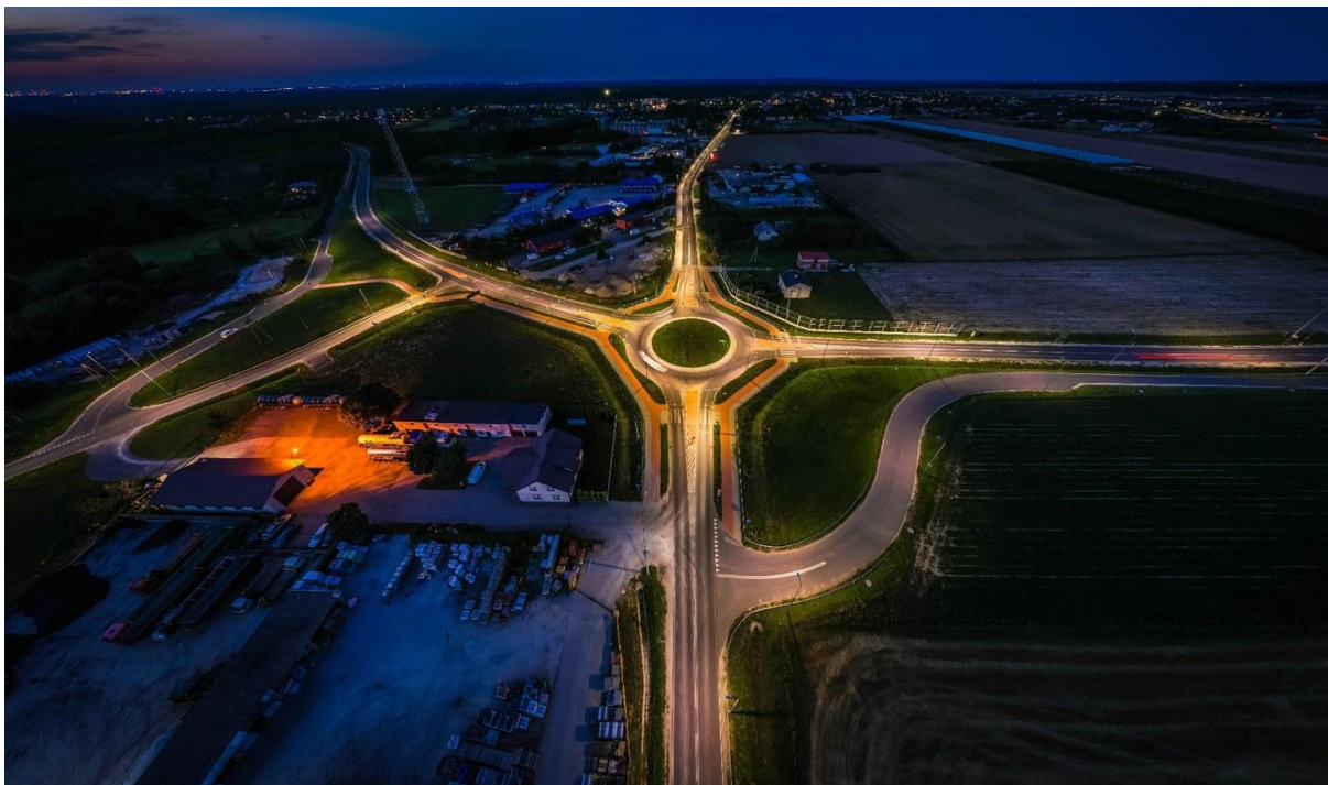
Rondo przy obwodnicy Gąbina nocą – węzeł drogowy otwierający dostęp do terenów inwestycyjnych GSRG
