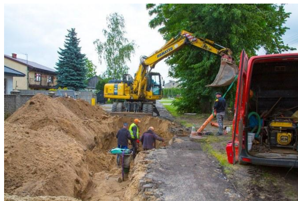
Prace budowlane na ul. Rogatki Żychlińskie – etap realizacji kanalizacji
