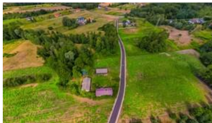
Przebudowa drogi Topólno–Czermno – widok z drona
