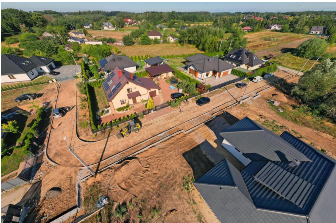
Przebudowa ul. Dobrowolskiego w Gąbinie
