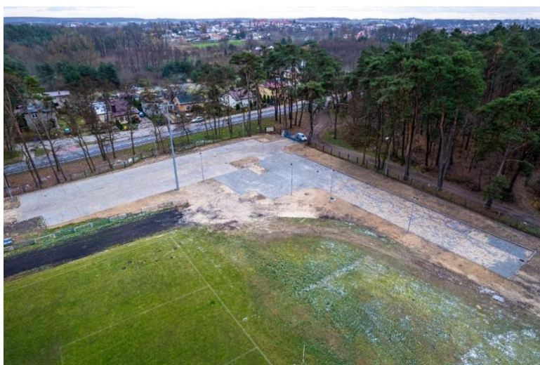
Tereny utwardzone oraz oświetlenie na stadionie leśnym w Gąbinie
