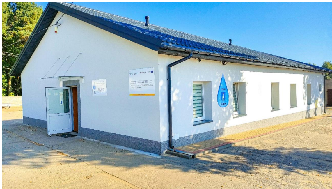
Termomodernizacja budynku administracyjno-biurowego należącego do Miasta i Gminy Gąbin w ramach projektu „termomodernizacja budynków użyteczności publicznej w gminach regionu płockiego”
