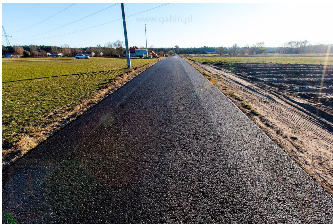
Przebudowa drogi gminnej 290605W Etap I (0+000 - 0+615)
