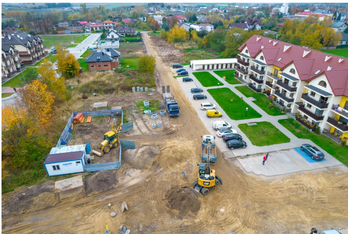
Przebudowa ulicy Bursztynowej w Gąbinie
