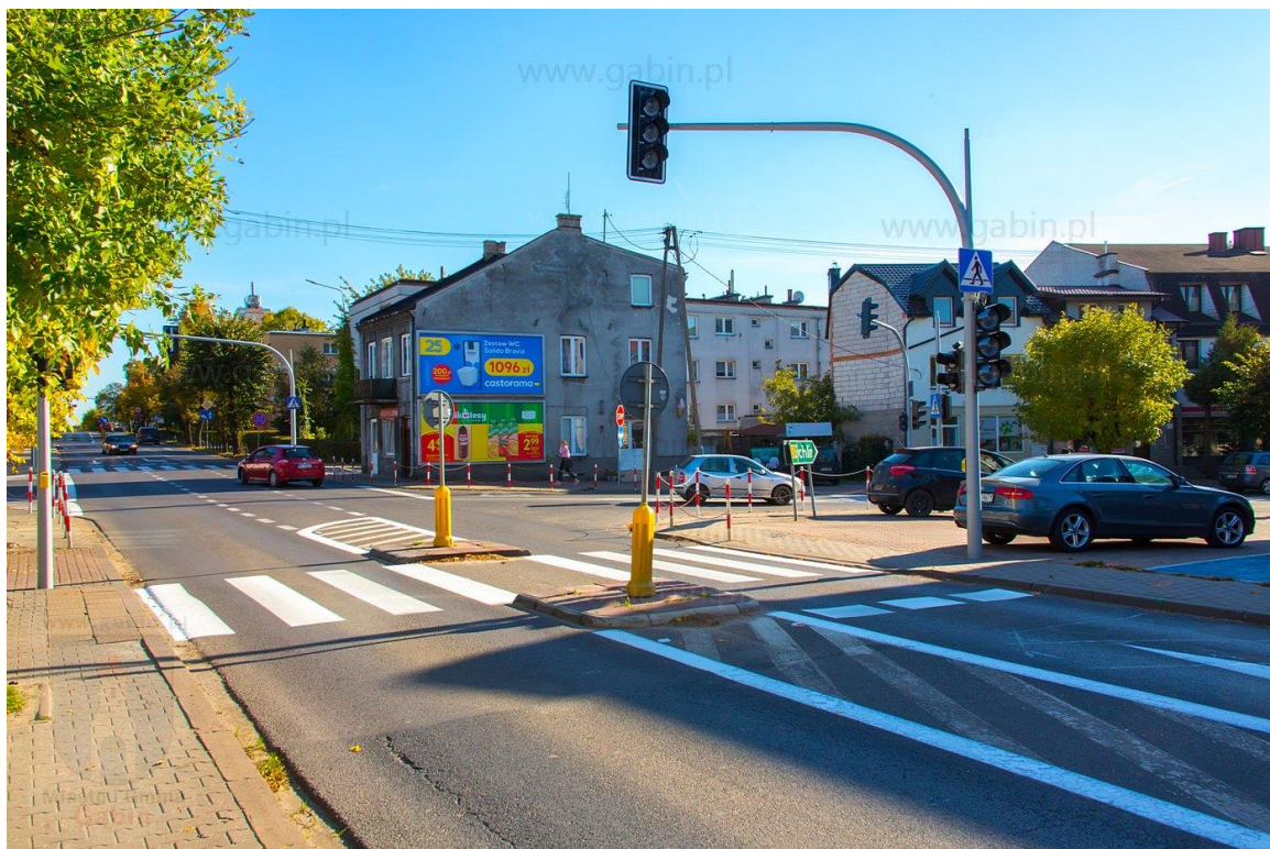
Przebudowa 4 przejść dla pieszych w Gąbinie na ul. Sławoja Składkowskiego, Kutnowskiej i Ciasnej
