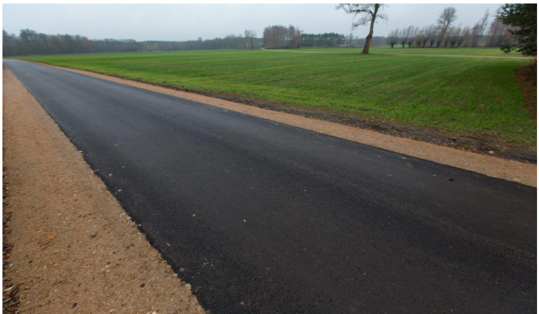
Przebudowa drogi gminnej Kępina- Plebanka
