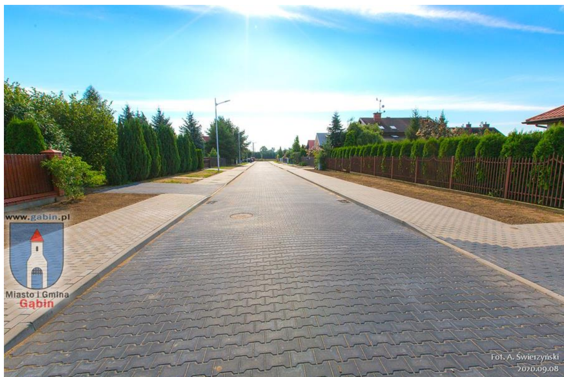
Przebudowa ulicy Różanej w Gąbinie
